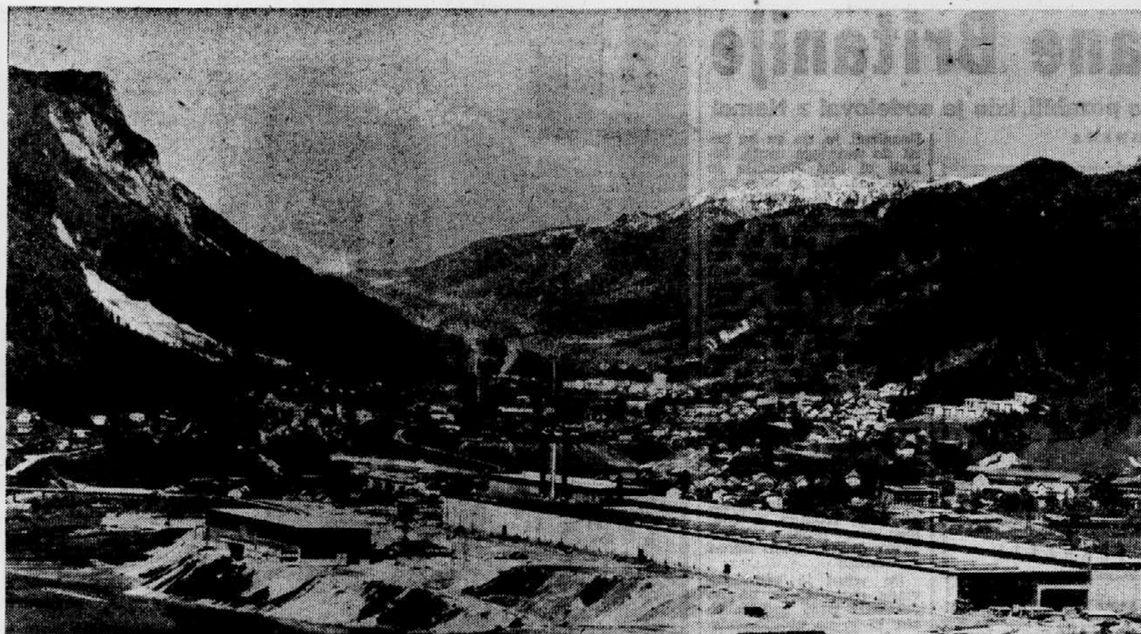
Na Belškem polju so v okviru rekonstrukcije zgradili nove valjarne. V pol kilometra dolgi bluming valjarni, ki jo na sliki vidimo v ospredju, zdaj preizkušajo nove stroje, da bi v kratkem začeli poskusno obratovati.
