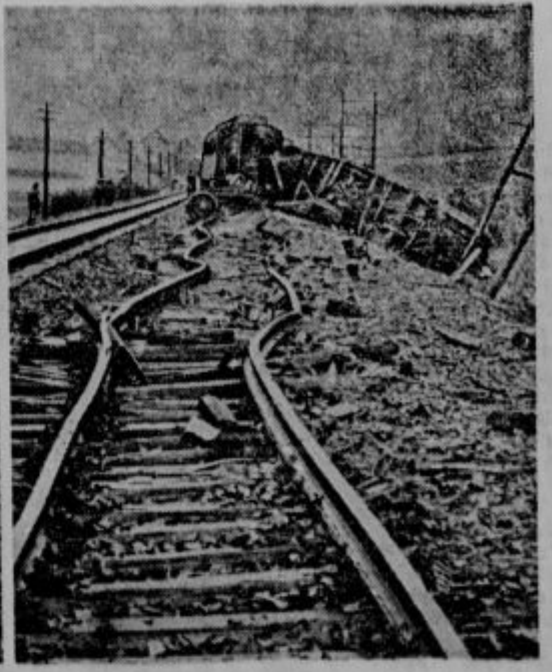
Dve slike o strašni železniški nesreči na progi med Apolda in Bad Sulza. Radi pokvarjenih tračnic je skočil brzovlak iz Stuttgarta s tira. Doselej so našli 5 mrtvih in 16 hudo ranjenih. Na levi sliki se posebno dobro vidijo skrivljene tračnice
