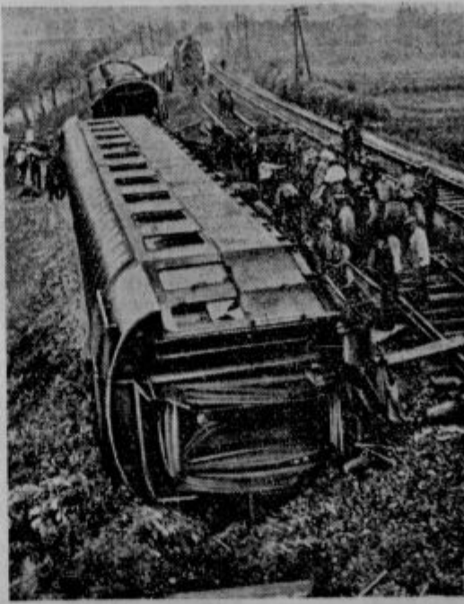
Dve slike o strašni železniški nesreči na progi med Apolda in Bad Sulza. Radi pokvarjenih tračnic je skočil brzovlak iz Stuttgarta s tira. Doselej so našli 5 mrtvih in 16 hudo ranjenih. Na levi sliki se posebno dobro vidijo skrivljene tračnice
