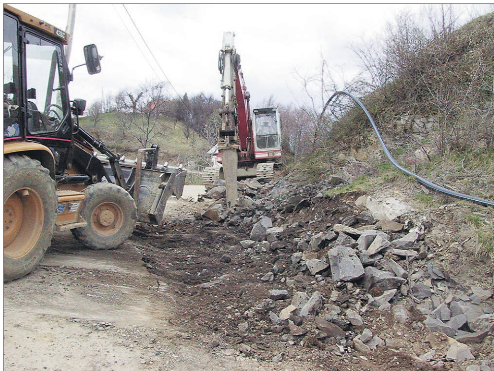
Gradnja vodovoda je v Haložah draga in naporna.
