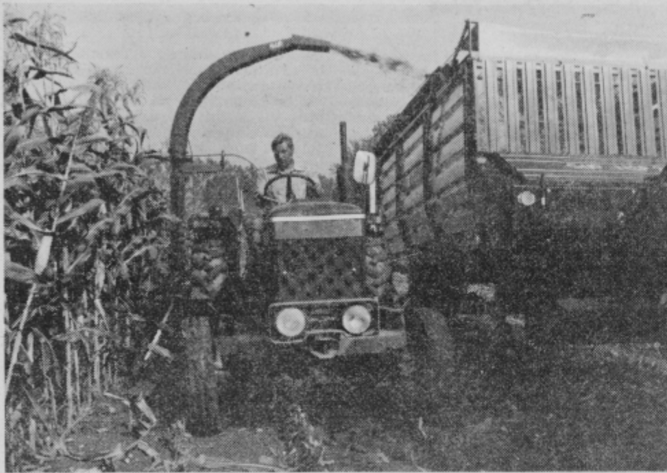
Najnovejši dosežek: kombajn za žetev žitaric in dvoredni silažni kombajn. Na sliki je dvoredni silažni kombajn.
