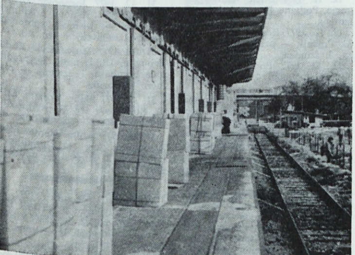
Tudi bankina skladišča je zatrpna s kartoni preje in balami sintetičke. Zaradi tega transportni delavci ne smejo voziti bremen z viličarji po bankini skladišča.
