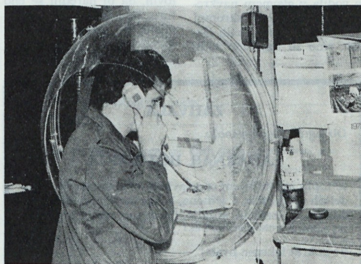
Zaščitna naprava pri telefonu vlagalnice omogoča delavcem normalni razgovor. Hrup, ki ga povzročajo stroji sukalnice jih nič več ne moti.
