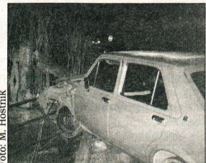
Šmartno, 8. decembra - Takole je nesrečni voznik s svojim vozilom skoraj zgrmel v reko Reko. Pri tem je bil močno poškodovan mostiček in ograja.
