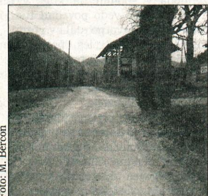
V občini je bilo lani asfaltiranih prek 30 km cest. Slika je iz Vintarjevca, kjer je črna cesta povezala samotne kmetije z dolino.
