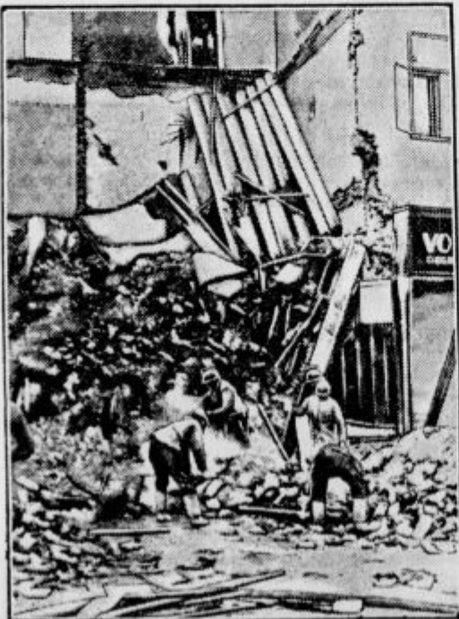
Razvaline dvonadstropne hiše, ki se je te dni podrla na Alserbachstrasse na Dunaju. Hiša je bila stara nad 100 let; pritličje so predelovali za trgovino ter pri tem s traverzami preobtežili oporne stebre. Na srečo je eden zidarjev opazil, kako popuščajo opore ter pravočasno opozoril delavce in stranke, da so rešili vsaj golo življenje.
