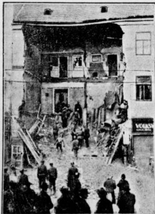
Razvaline dvonadstropne hiše, ki se je te dni podrla na Alserbachstrasse na Dunaju. Hiša je bila stara nad 100 let; pritličje so predelovali za trgovino ter pri tem s traverzami preobtežili oporne stebre. Na srečo je eden zidarjev opazil, kako popuščajo opore ter pravočasno opozoril delavce in stranke, da so rešili vsaj golo življenje.
