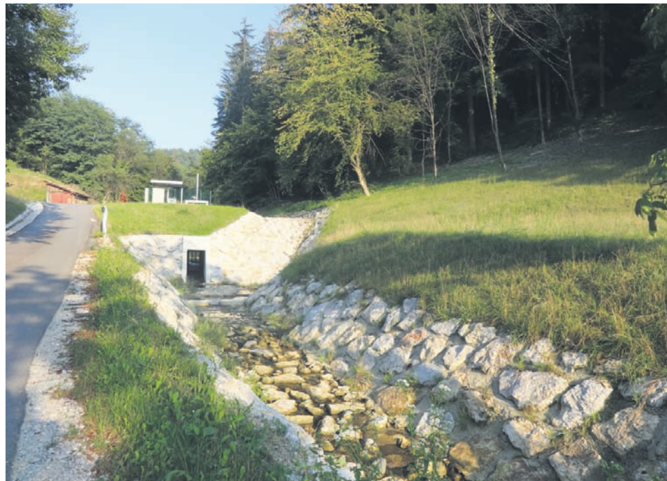
Tako so lansko leto preuredili potok, ki priteče s sv. Tomaža. Zgradili so tudi zapornice, ki omogočajo boljšo pretočnost. (Foto: KP)
