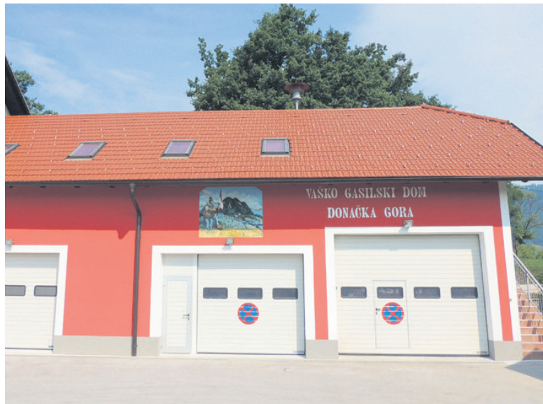
Po zaslugi pridnih rok gasilcev ima vaško-gasilski dom prenovljen del ostrešja, prebarvano fasado in urejeno okolico. Člani društva se bodo posvetili še urejanju parkirišč.
