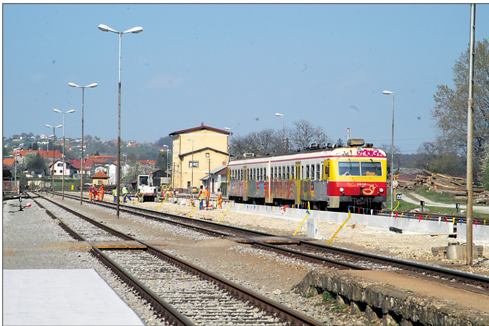
Rekonstrukcija železniške proge poteka tudi na železniški postaji v Ptuj.
