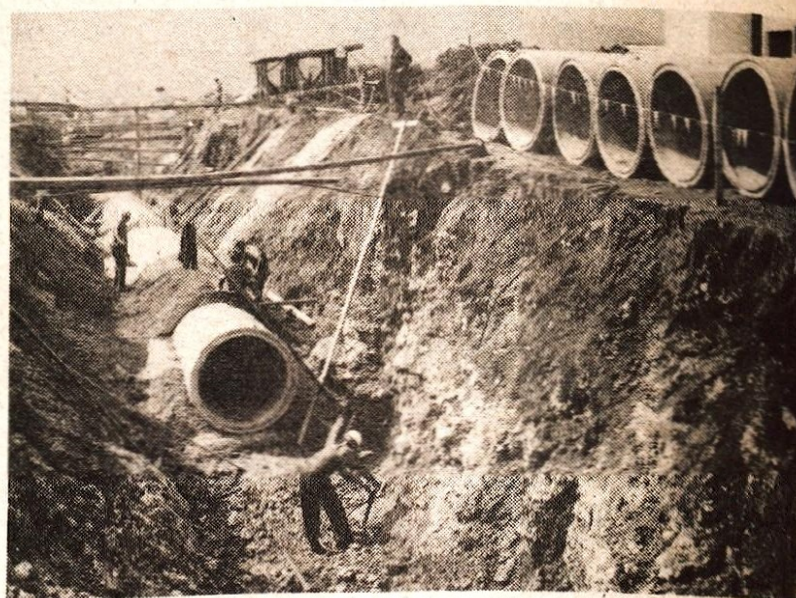
Zlato polje — V globino poprečno 6 metrov delavci polagajo ceno 1,4 metra; rajonski zbirnik na Zlatem polju, eden največjih objektov programa izgradnje kanalizacije v občini, bo imel propustnost 4000 l/s odpadne vode na sekundo. — Foto: F. Perdan
