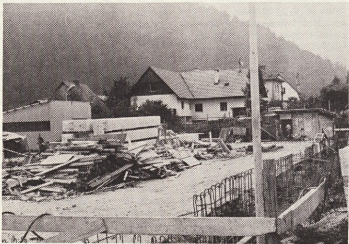
Pričetek gradnje nadomestnega skladišča na prostoru, kjer je stal skladiščni šotor. Gradnja montažnega skladišča bo končana predvidoma konec oktobra. (Fotografija je nastala 1. 9. 1983)
