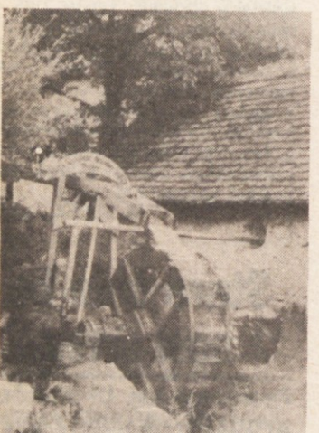
OB POTOKU STARI MLIN — Turistično društvo Pišce je odklopilo mlin ob izviru Gabernice in ga obnovilo.
