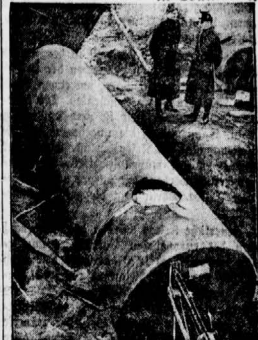
Der Unglücksstank, dessen Verschlussklopf durch die Explosion abgerissen wurde.
