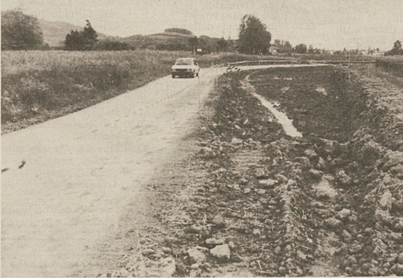
Gradbišče nove ceste
