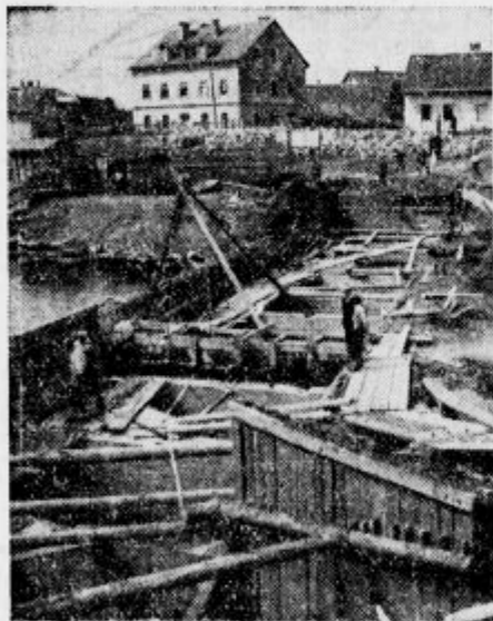
Betonski del zatvornice na »Spici« z 9 kanali
