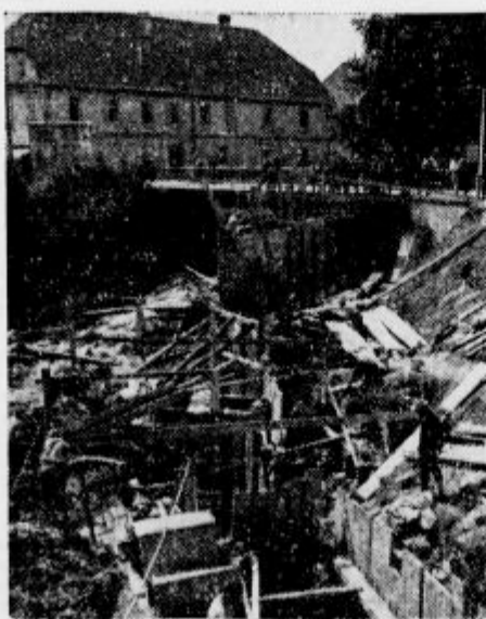
Graditev opornega zidu in opornika za most ob Gradaščici
