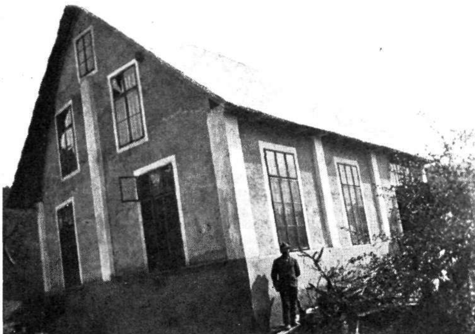
Stavba, v kateri je bila tudi strojnica dobračevske elektrarne Lastnik fot. Dane Primožič
