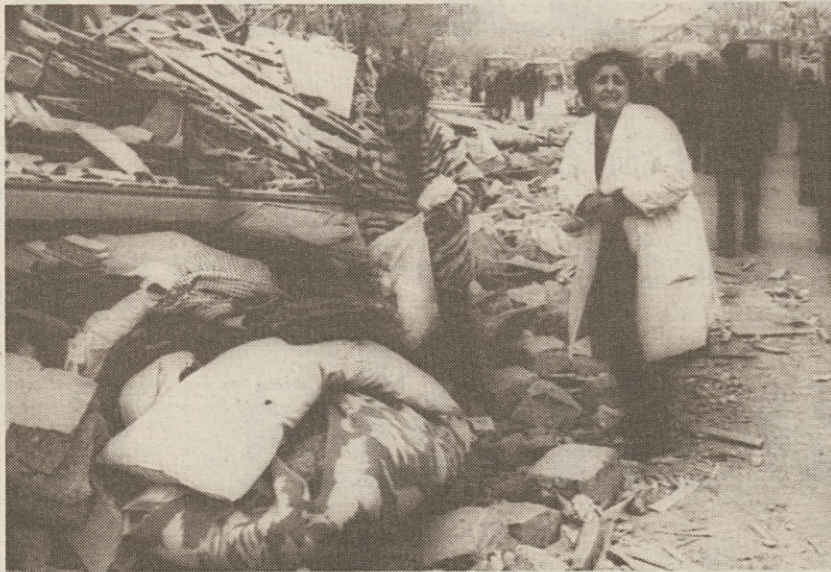
Prebivalci Spitaka. Potres je porušil večino stavb, tudi enonadstropnih hiš (AP)
