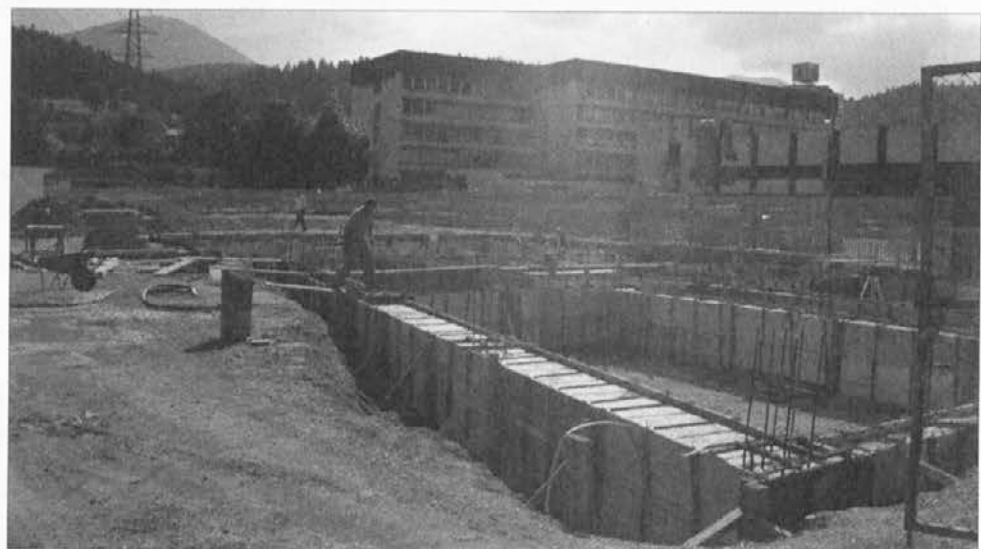
Betoniranje temeljev (september 2005).
