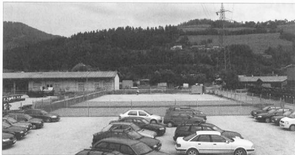
Prostor za poslovno zgradbo je že ograjen (avgust 2005).
