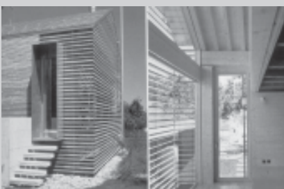
□ Marcus Wespi, Jerome de Meuron, hiša v Fawil-u, Švica Zastrta vhoda partija - zunanja opna iz horizontalno nameščenih letev, izolativno steklo za njo (vir slike: Häuser 2/2001)
