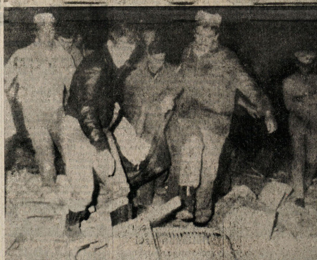
Gasilci na delu med ruševinami restavracije
