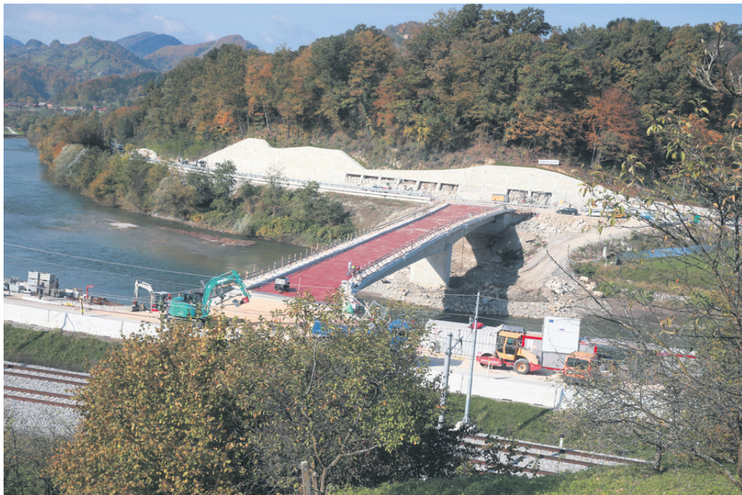
Gradnja mostu čez Savinjo v Marija Gradcu
