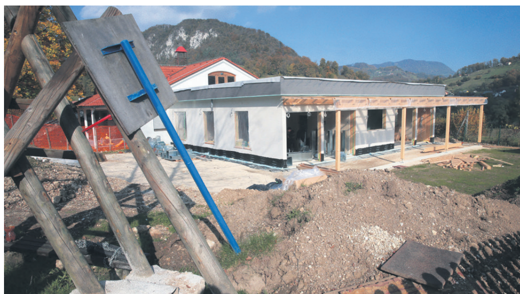
Gradnja prizidka k vrtcu v Rimskih Toplicah
