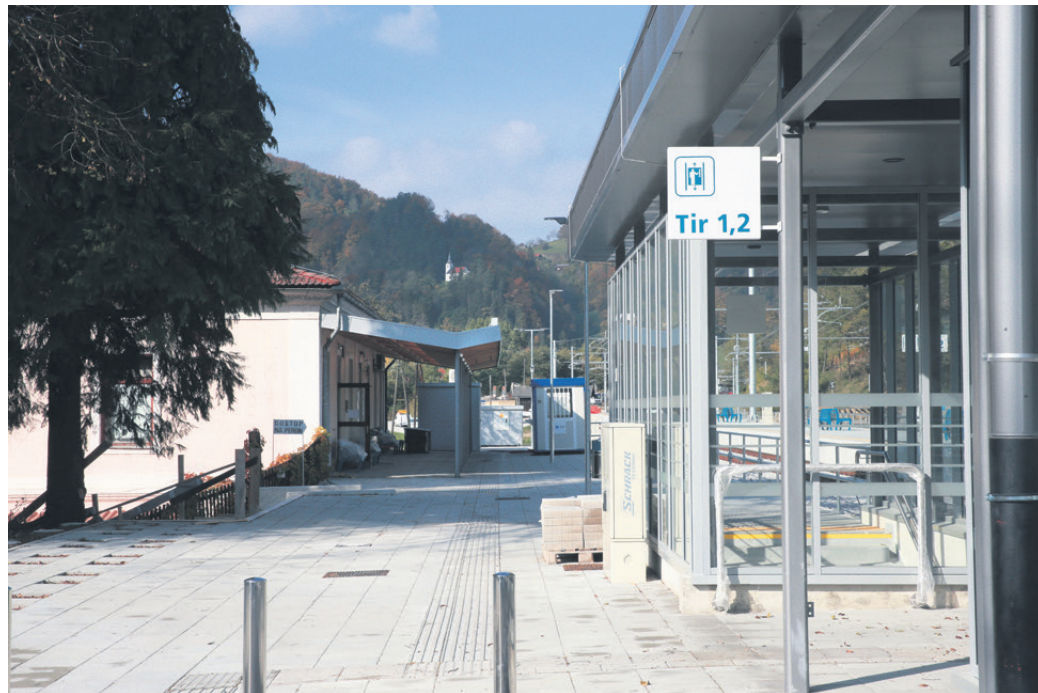
Obnova železniške proge in postaje v Rimskih Toplicah
