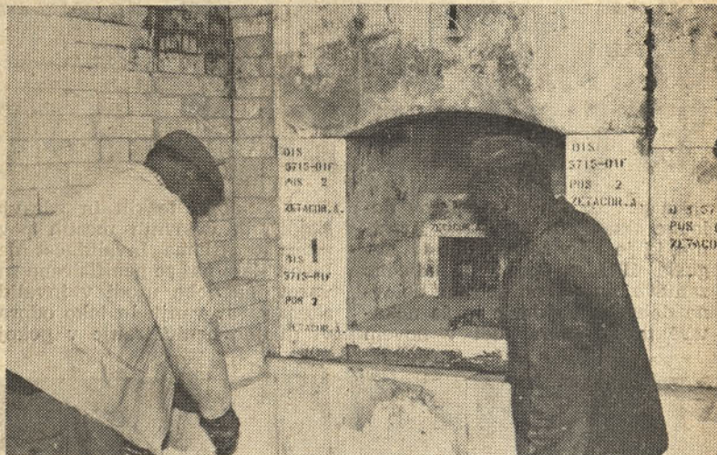
Zidarja Fišnar Ivan in Crnkovič Milan pri obnavljanju A. banje
