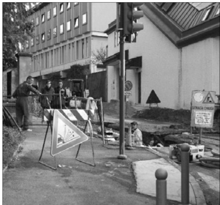
Gradbišče na koncu Semeniške ulice
