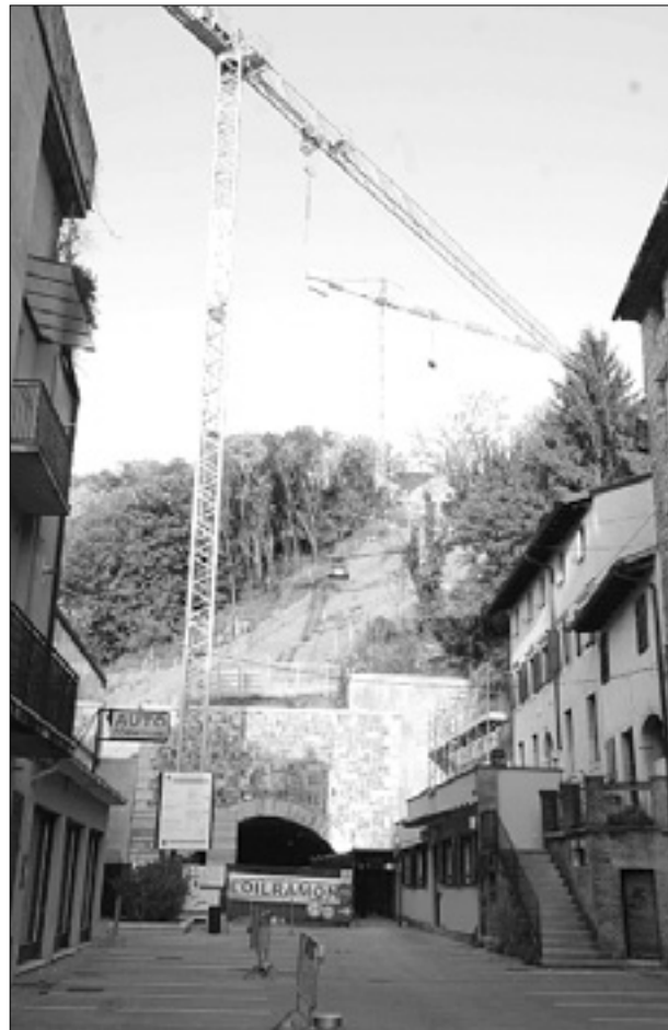
Predor Bombi in gradbišče na grajskem griču
