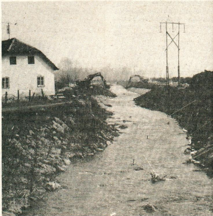
Dela na melioraciji so v polnem teku. Marčevski posnetek na Radomlja I. (Foto: S. Jesenovec)
