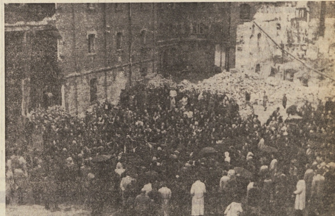
Prvi posnetek dvorišča Rižarne neposredno po osvoboditvi. Ruševine krematorija
