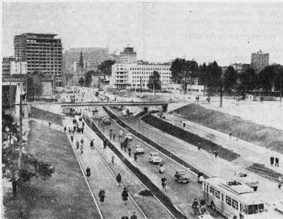
Pogled na novi podvoz Celovške ceste v Ljubljani
