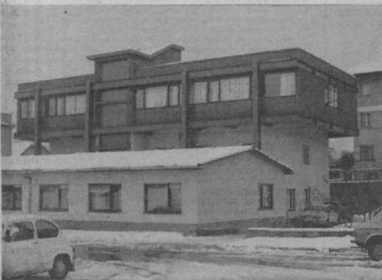
Poslovna stavba GP Bežigrad se ponaša z nenavadno »kapo«. Sami so si zamislili način nadzideva, saj sicer temelji ne bi zdržali novega nadstropja, pa so si pomagali z oporniki – zdaj lahko stavbo dvignejo še za eno ali dve nadstropji.
