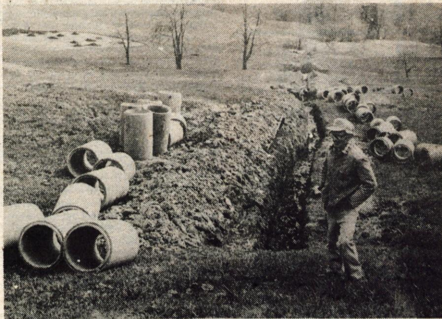
Ukročen hudournik — Ker je ob vsakem večjem nalivu voda drla čez travnik, s ceste pa odnašala pesek in ga nosila po travi, vaščani Leskovicke gradijo odvodni kanal, v katerega bodo ujeli hudourniško vodo. Foto: F. Perdan
