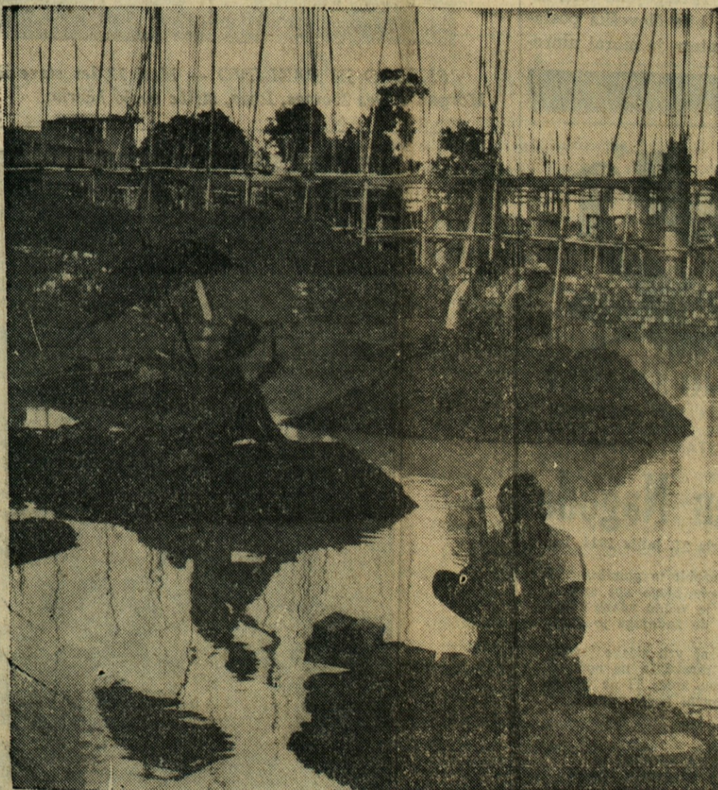
PO STARI NAVADI — Ko prične monsumsko deževje je večji del mesta Dacca v vzhodnem Pakistanu pod vodo. Delavci so se spravili vsak na svoj otok in pripravljajo opeko za gradnjo stavbe v ožadiju.
