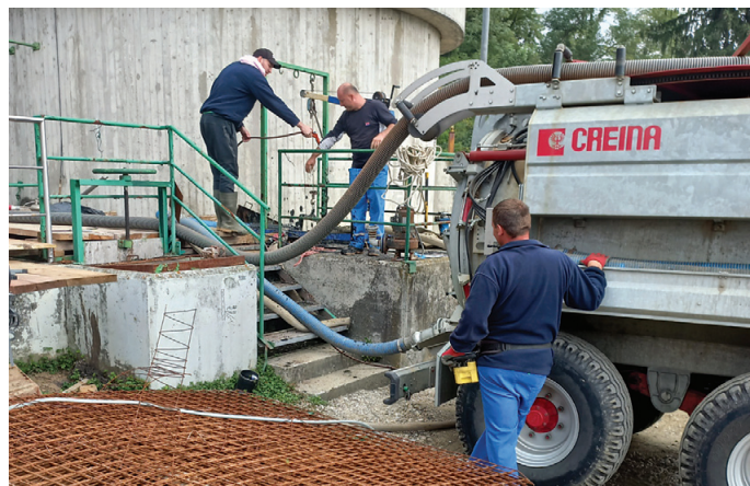
Ob vsaki zaustavitvi morajo delavci črpalke razstaviti in očistiti.
