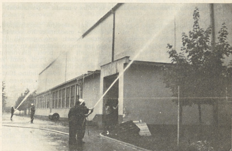
V nekaj minutah so že delovale črpalke gasilcev iz Zg. Kašlja
