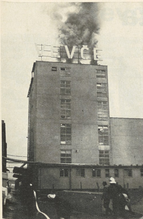
»Požar« je izbruhnil v stavbi oddelka za premazovanje papirja
