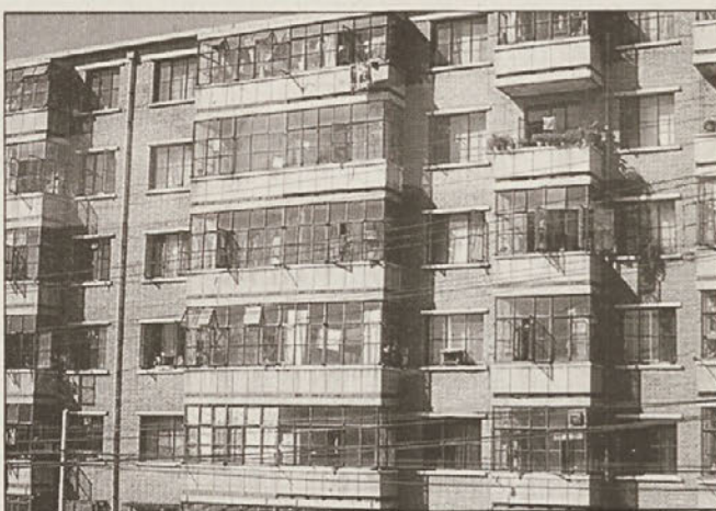
Stanovanjski blok, na katerem so si stanovalci skoraj vse balkone zasteklili in s tem pridobili nekaj dragocenih kvadratnih metrov površine.
