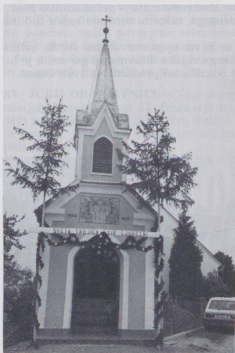
Obnovljena nuskovska kapela
