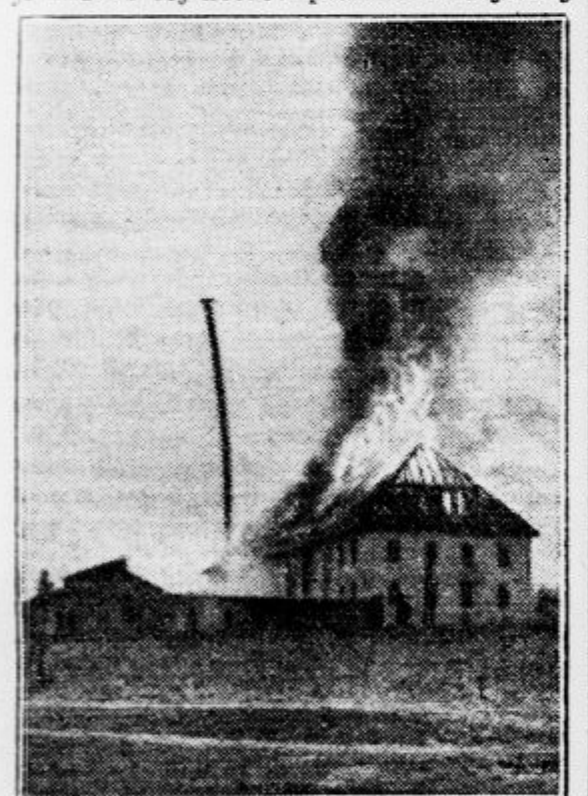
Slika požarne nesreče. Dimnik, ki ga bodo na novo montirali, se je tedaj upognil
