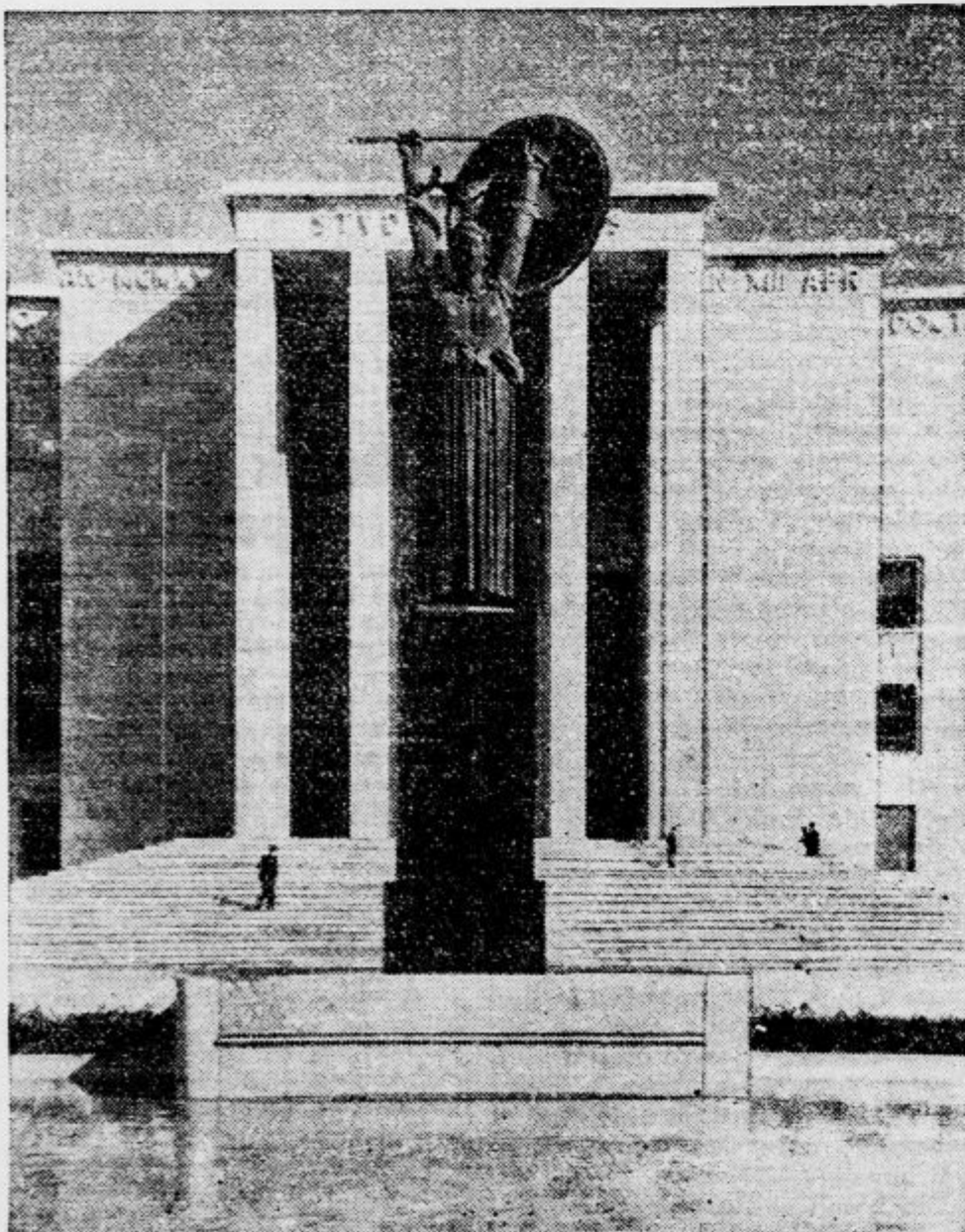
Italijanski ministrski predsednik je pred kratkim otvoril novo vseučiliško četrto v Rimu. Naša slika nam kaže del pročelja palače za rektorat. Kiparska dela je oskrbel kipar Martini
