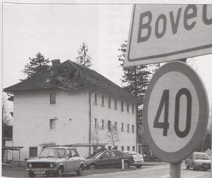
Na skoraj 1000 objektih je potres zapustil sledove, 150 hiš bo treba popolnoma na novi sezidati.
