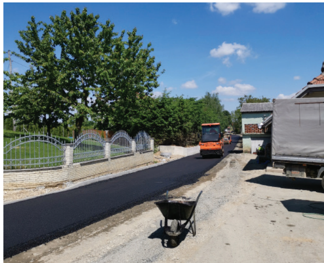
Dela na lokalni cesti
