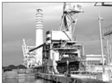
Tržiška termoelektrarna BONAVENTURA
