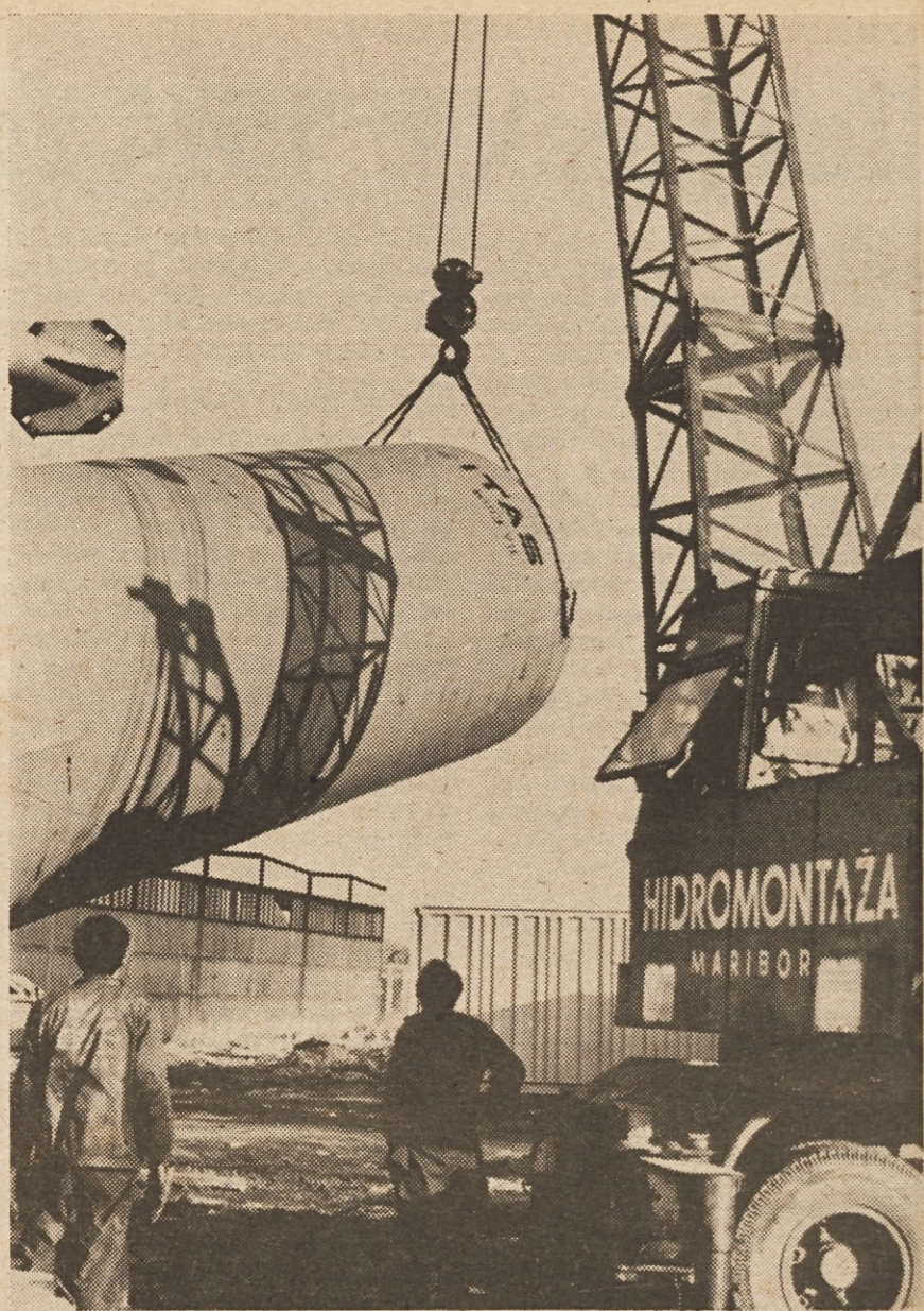
Postavljanje 100-tonskega silosa za kremenčev pesek, oz. živec.
