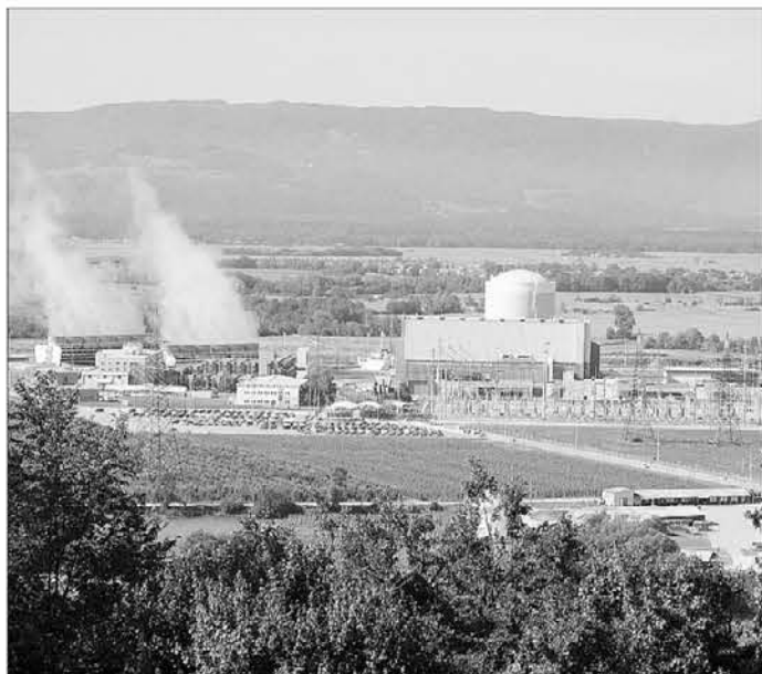
La centrale nucleare di Krško in Slovenia
