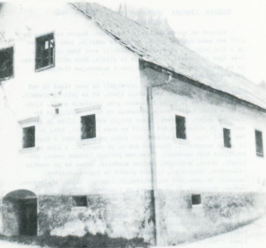
Pri Anžičku v Bistrici, okenski okviri so iz zelenega peroškega kamna, okna z železnimi „gautri“
