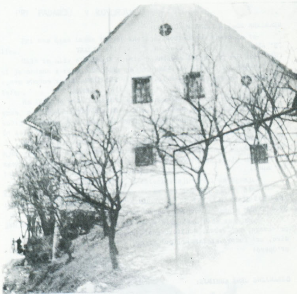
Severni del Mokrove hiše v Kovorju, okna z železnimi križi.
