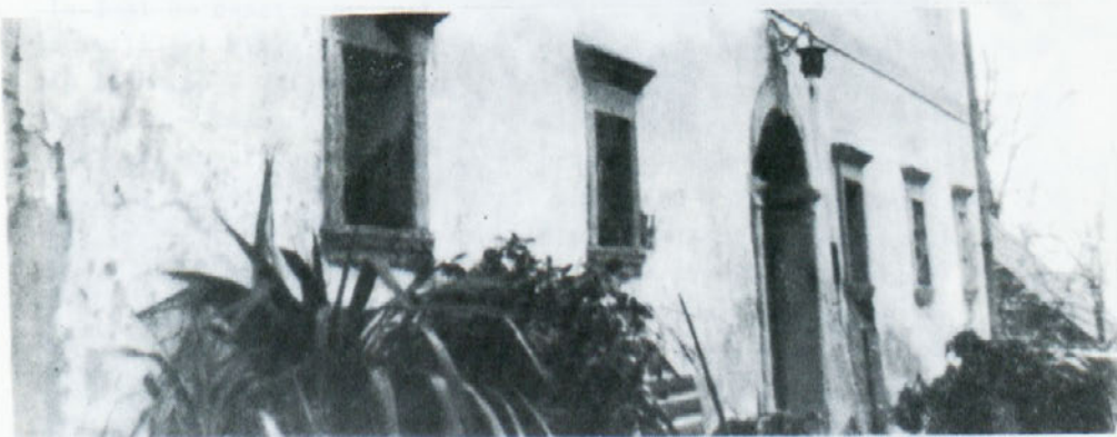
Portal in okenski okvirji iz zelenega perasekega kamna Pri Ahcu na Hudem
