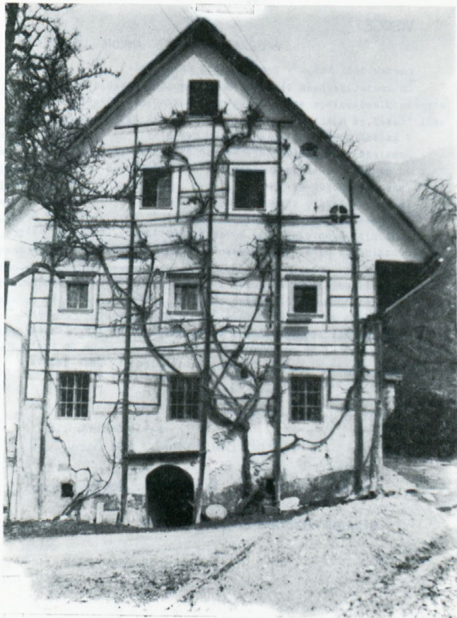
Južni del Justinove hiše v Palovičah, zanimivi so iz kamna klesani okvirji oken.
