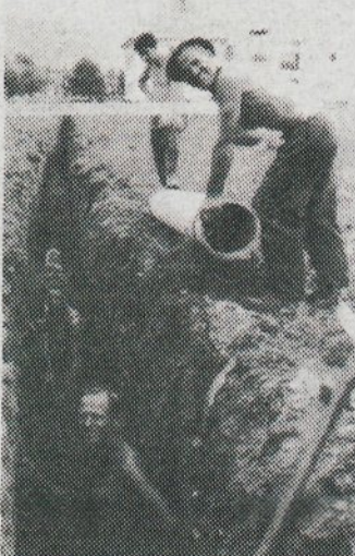
Polaganje cevovoda od Most proti Suhadolam v letu 1963.
