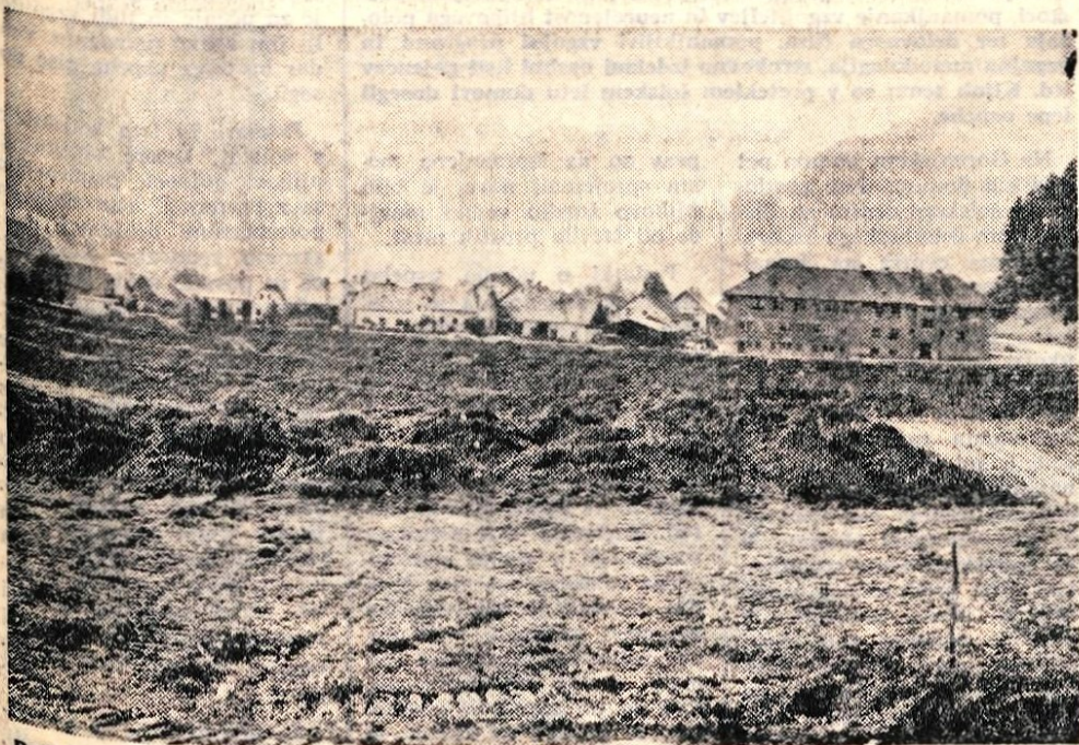
Podjetje Alples iz Železnikov gradi na Češnjici nove proizvodne obrate, ki bodo med največjimi v Jugoslaviji, saj bo njihova površina znašala 16.000 kvadratnih metrov. — Foto: F. Perdan
