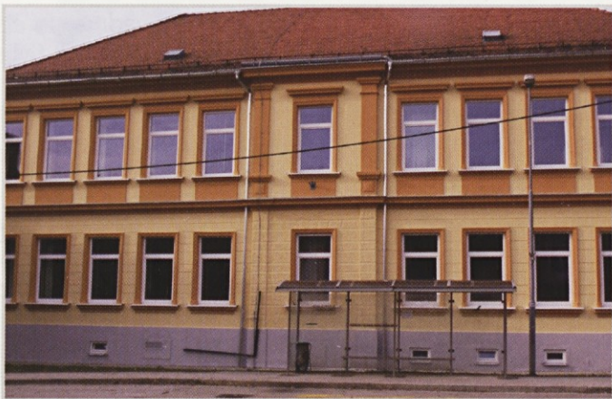
Prenovljena stara zgradba OŠ Miklavž pri Ormožu
