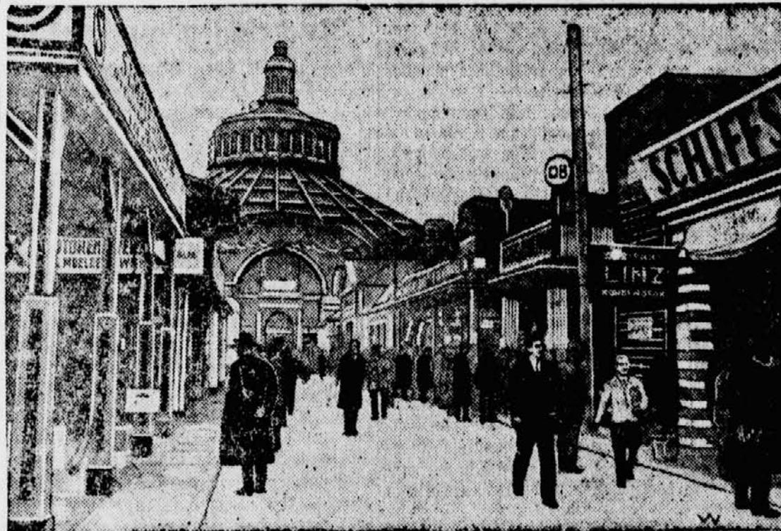
Das Messegelände, im Hintergrunde die riesige Messehalle.
