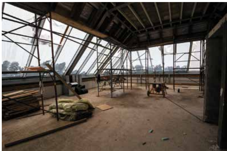
Delno panoramska streha na podstrešju, kjer se bodo nahajala prenočišča
