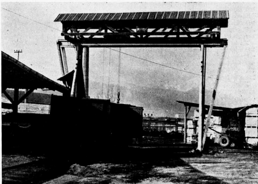
Glavni vhod za material
