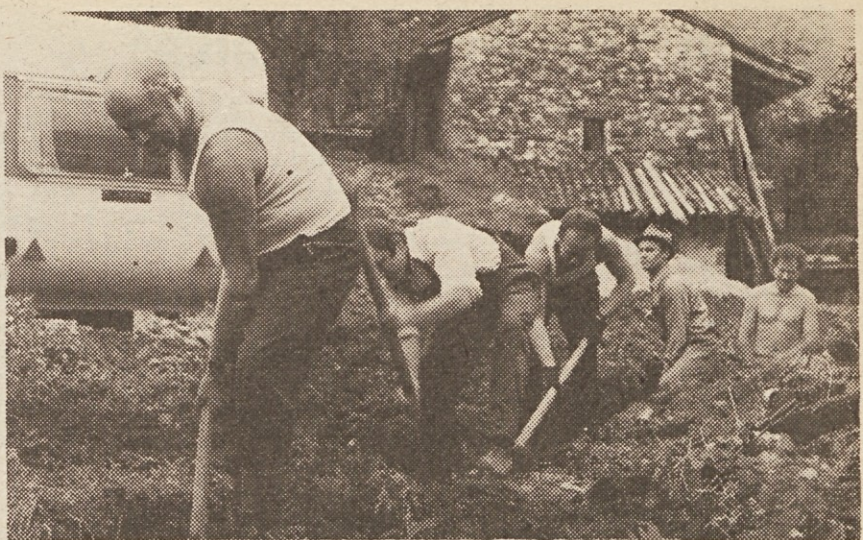
Prostovoljci so se lotili izkopa za vodovod.
