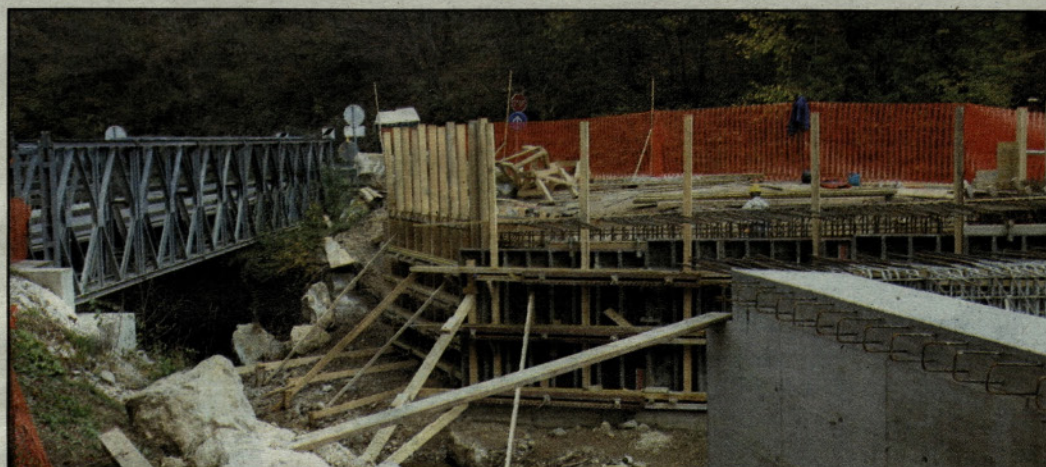
Most v gradnji
