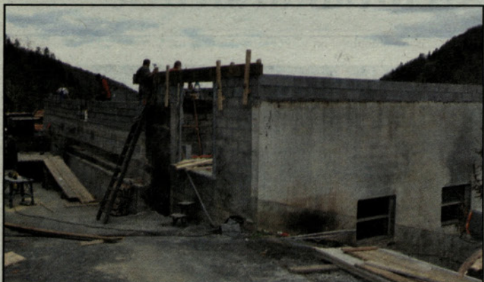
Štirinajst dni po uliti plošči že zidajo
