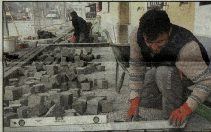
Minuli teden so začeli z natančnim opravljanjem polaganja granitnih kock
