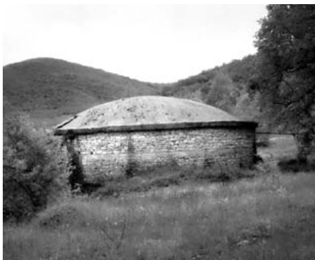
Del vasi z velikim vodnim zbiralnikom za napajanje parne lokomotive na ozkotirni železnici.
